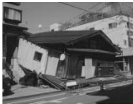
新潟中越地震で倒壊した家屋
