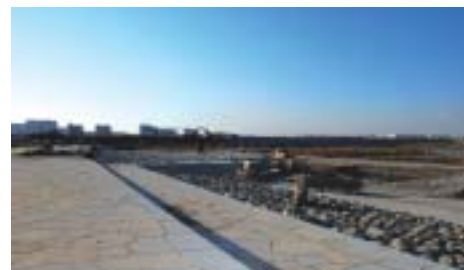
水上ステージを建設中です
