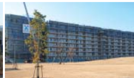
上層階まで立ち上がってきたマンション
