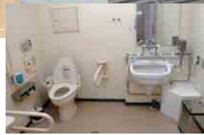
▲市役所第二庁舎1階・多機能トイレ
