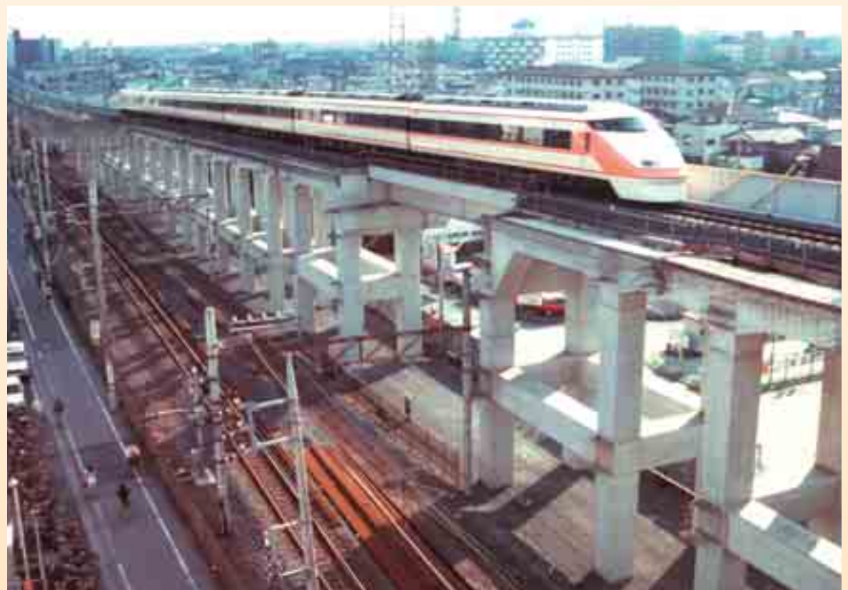
▲一部（下り）が高架となった東武鉄道伊勢崎線（南越谷一丁目付近）
