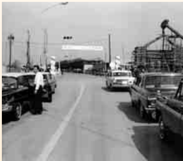
▲国道4号バイパスが全線開通（※2）
