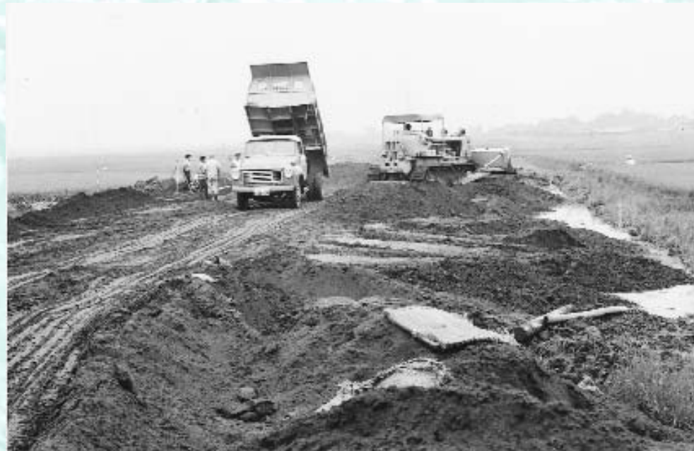
▲国道4号バイパスの工事が開始〔昭和39年〕
