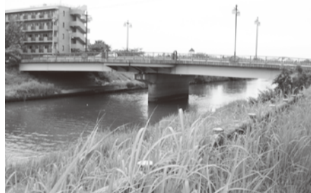
今年度修繕工事を行う千代田橋
