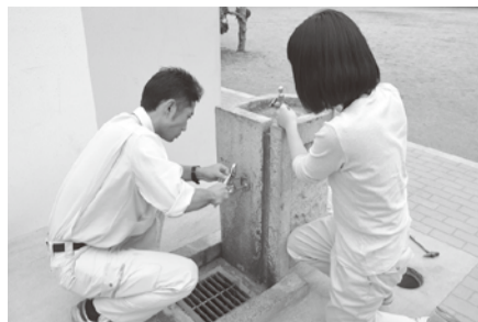
公園内の水道修理の様子。簡易な作業は市職員が行います
