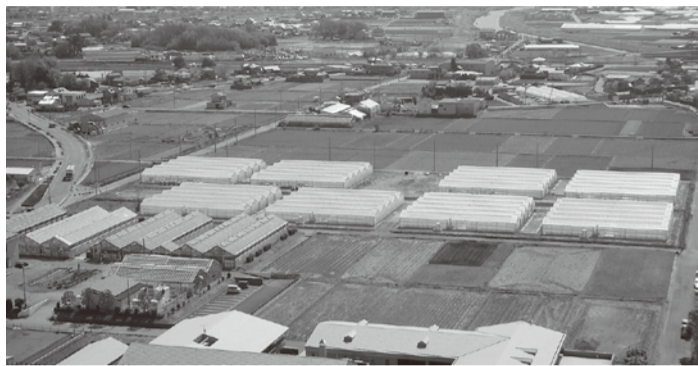
ビニールハウスが並ぶ越谷いちごタウン
