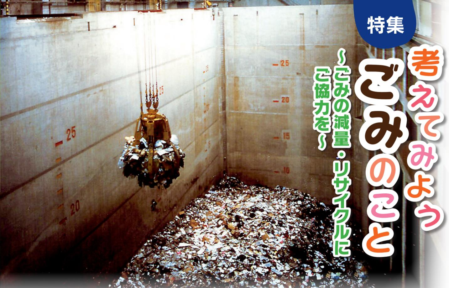
▲約1万トンのごみが溜められるごみピットの様子。燃えるごみは東埼玉資源環境組合第一工場のごみピットに集められ、巨大なクレーン(1つかみ約2~3ト)で、ごみが安定して燃えるようにかき混ぜてから、焼却炉へ運ばれます
