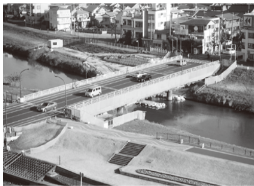
▶災害に備えて橋長15m以上の重要な橋りょうの耐震化を計画的に進めています(新平和橋の耐震整備工事)
