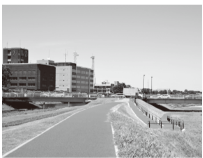
長寿命化修繕計画に基づき補修工事を実施した平和橋(左)と新平和橋
