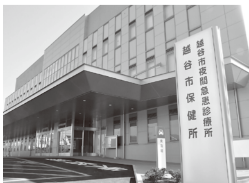
▶保健衛生体制と救急医療の充実を図ります(平成27年の中核市移行に伴い設置した保健所・夜間急患診療所)
