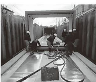
幹線排水路の整備
