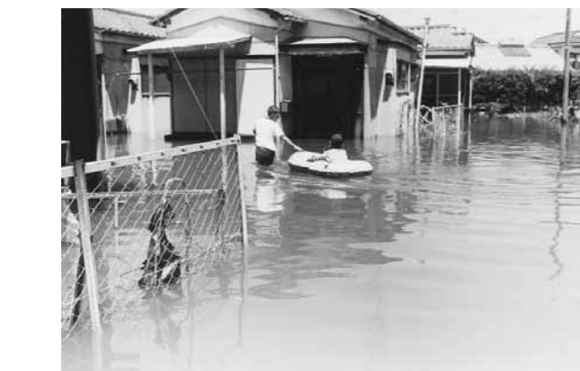
昭和61年10月 台風10号による被害の様子
