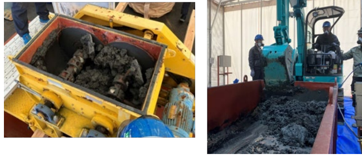
図 9 資材混合状況（左：小型攪拌装置、右：小型バックホウ）（No. S4）
