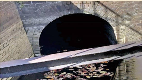
樋管トンネル
