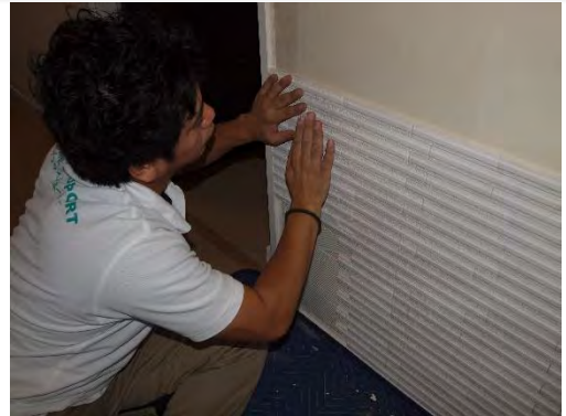
【エコカラット施工風景】
