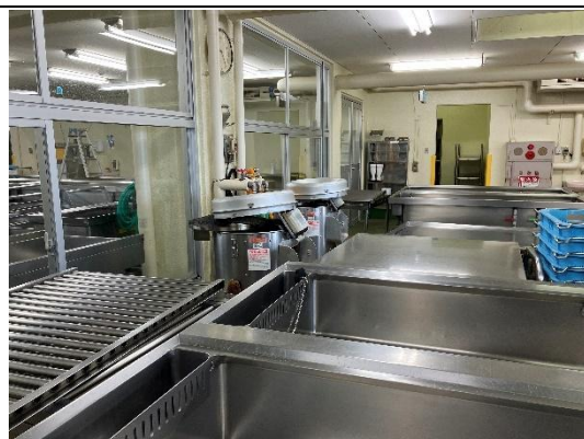
② 検収・下処理室
