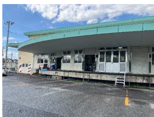
⑭ プラットホーム
