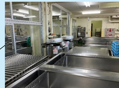
検収・下処理室
