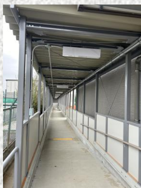
↑ 既存校舎と接続する 渡り廊下
