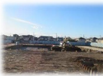
山留工事・土工事
