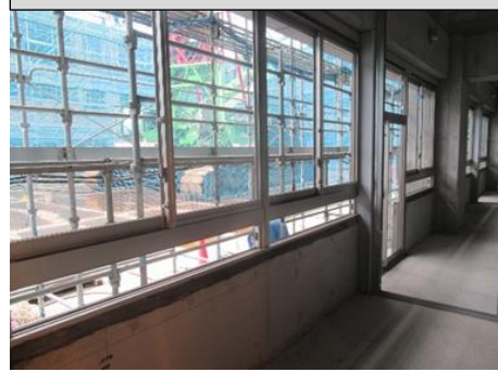
北棟第1工区・1階室内サッシ取付工事
