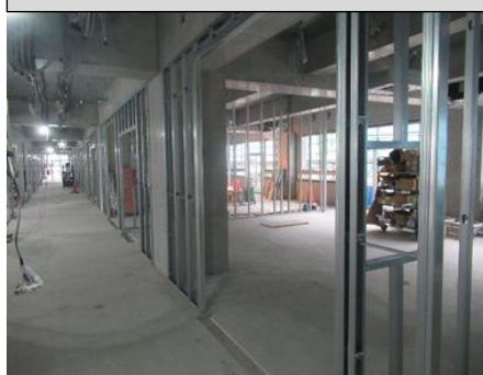
北棟第2工区・1階室内仕切工事
