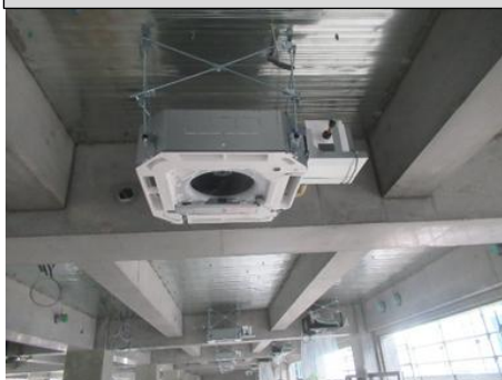
北棟第1工区・1階天井空調設備工事
