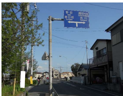
図 1-1 道路標識（大型-独立柱）
