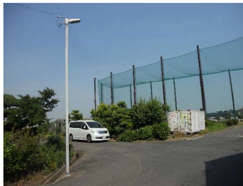
図 1-5 道路照明灯（独立柱）
