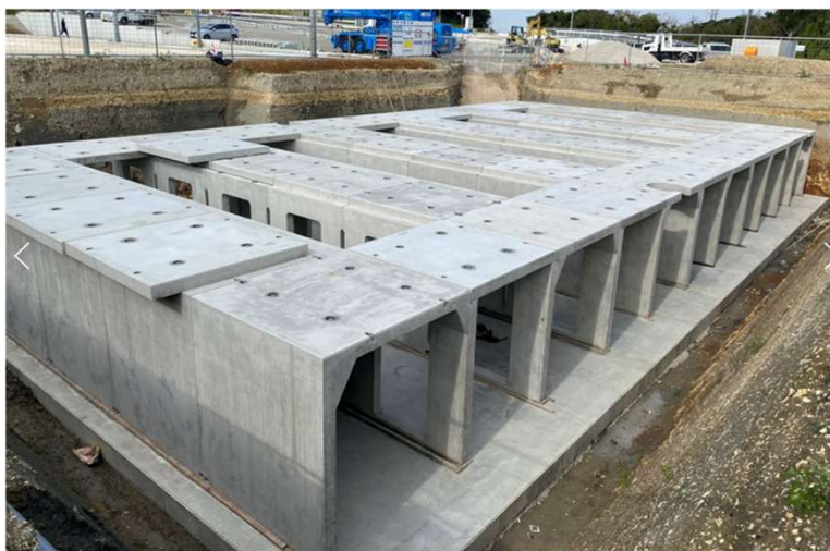
プレキャスト式雨水地下貯留施設
