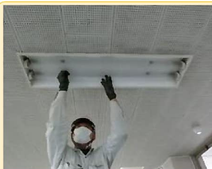
蛍光灯の反射板の取り外し
