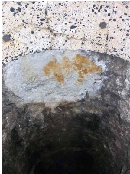
①煙突用石綿断熱材
