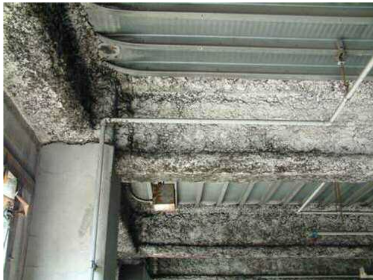
②石綿含有吹付けロックウール
