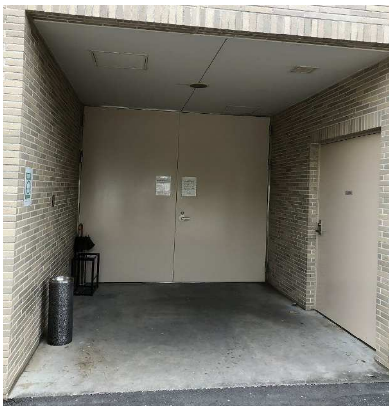
(バックヤード出入口)
