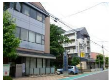
旧日光街道の歴史的な雰囲気配慮した建築物の景観
