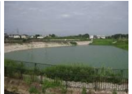
西大袋土地区画整理事業第1号緑地 (調整池)
