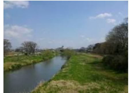
大砂橋から流軸方向上流を望む
