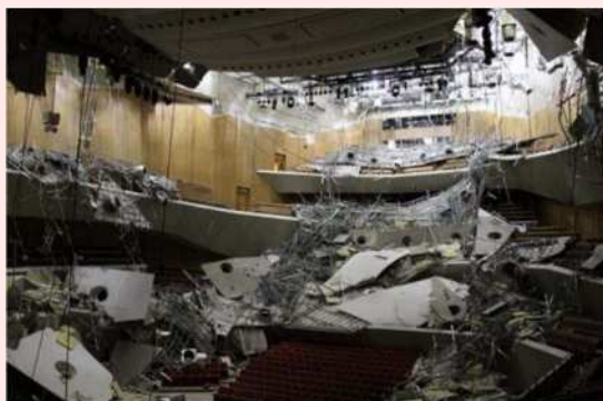
東日本大震災の際の特定天井脱落の被害
