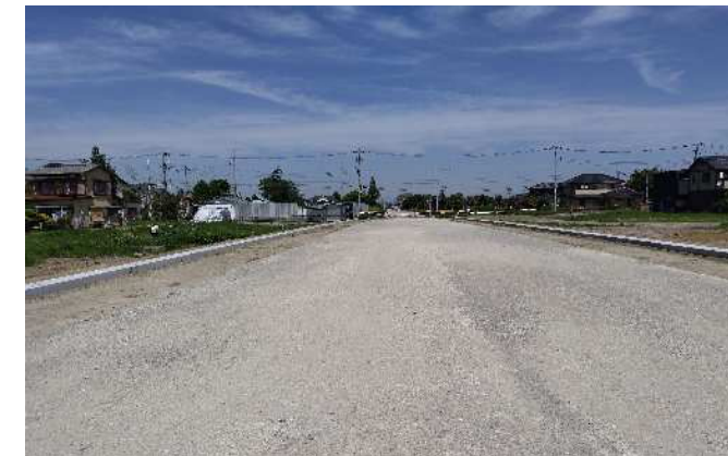
整備箇所（南側から北側を撮影）
