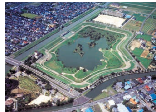
拡幅された新方川と大吉調節池
