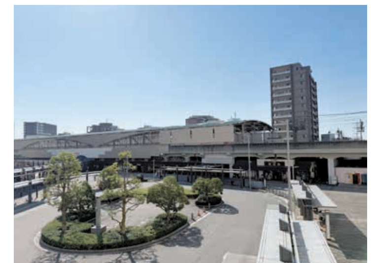
東武鉄道伊勢崎線線増連続立体交差事業(越谷駅付近)
