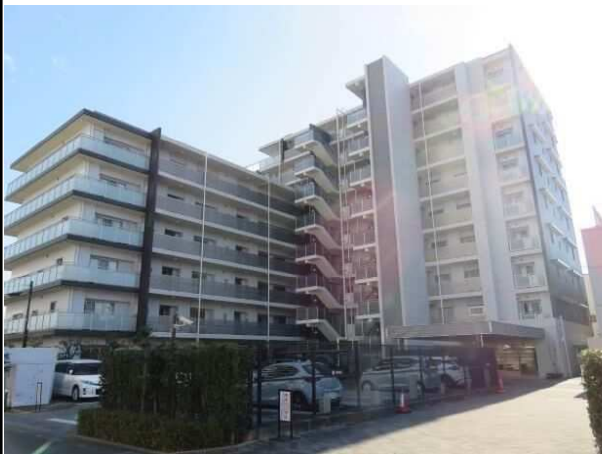
〔写真〕 ※ 〔建物 北西から〕
