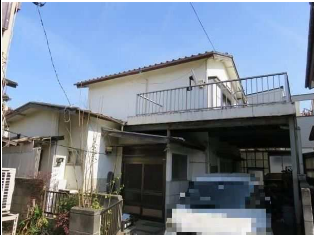
〔写真〕※〔建物 南西から〕
