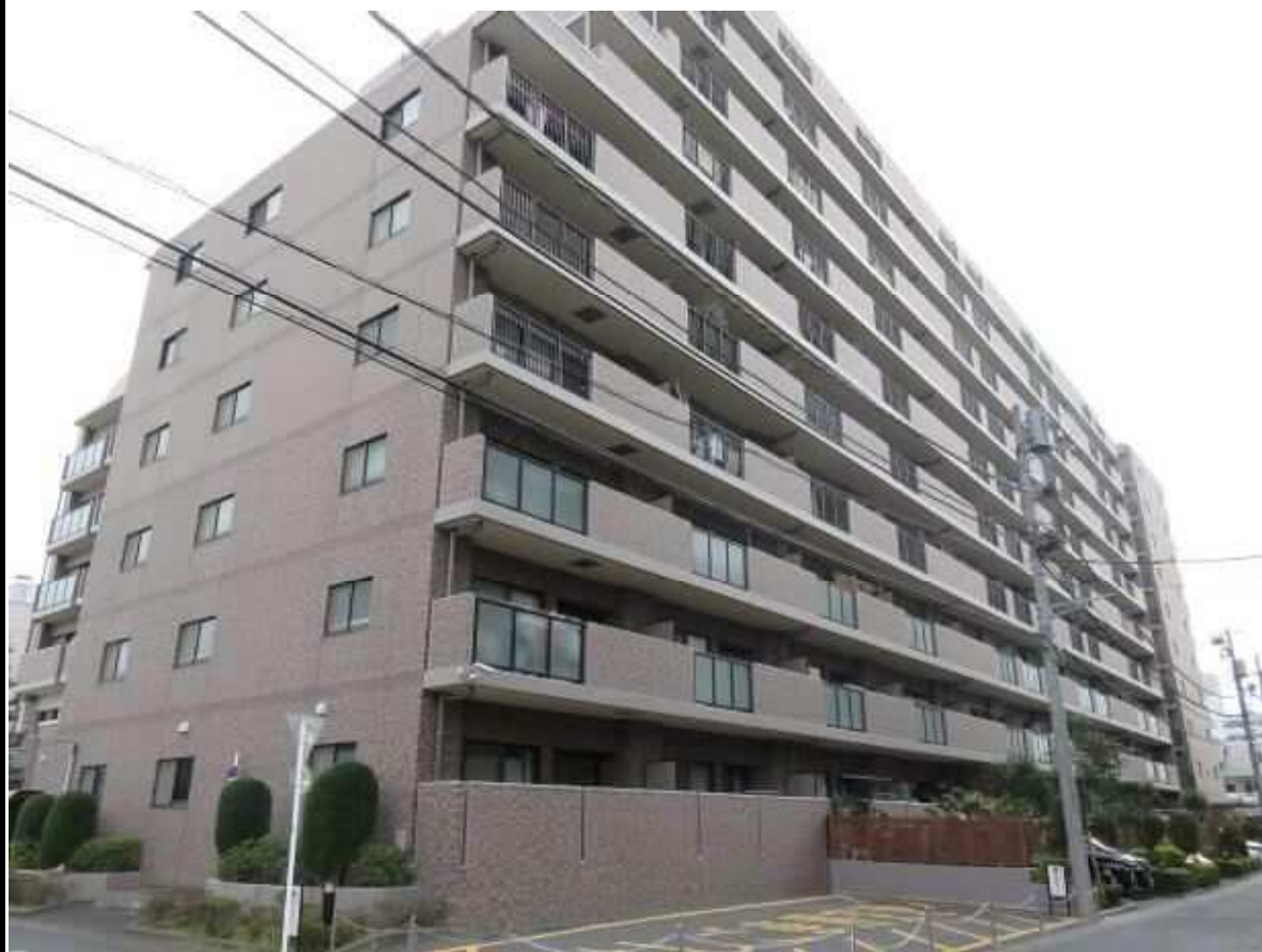
[写真] ※ [建物 北西から]
