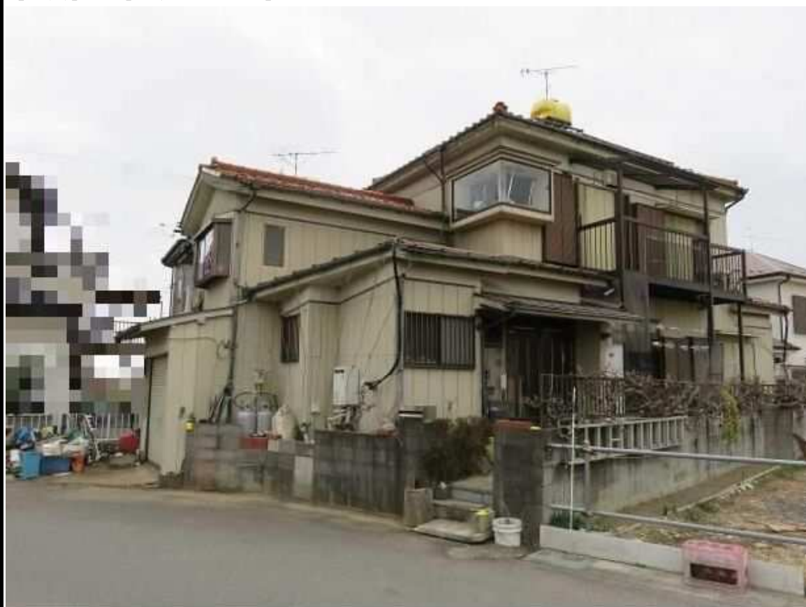
〔写真〕※〔建物 西から〕
