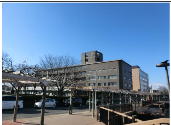
葛西用水ウッドデッキ
