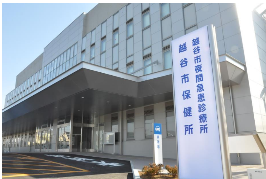
平成27年4月の中核市移行に伴い設置した保健所 同施設には夜間急患診療所を併設し救急医療の充実を図っています
