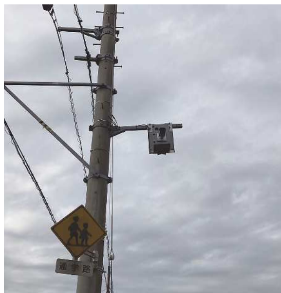
通学路に設置した防犯カメラ
