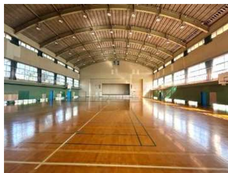
地域体育館の長寿命化改修 (北体育館の様子)
