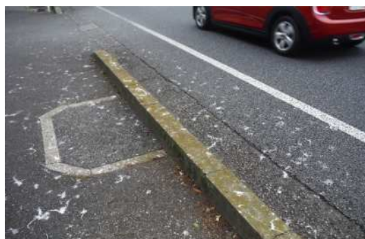
対策前の糞で汚れた道路
