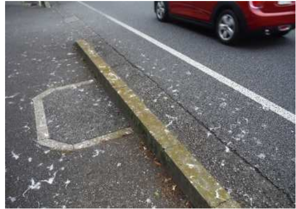
対策前の糞で汚れた道路
