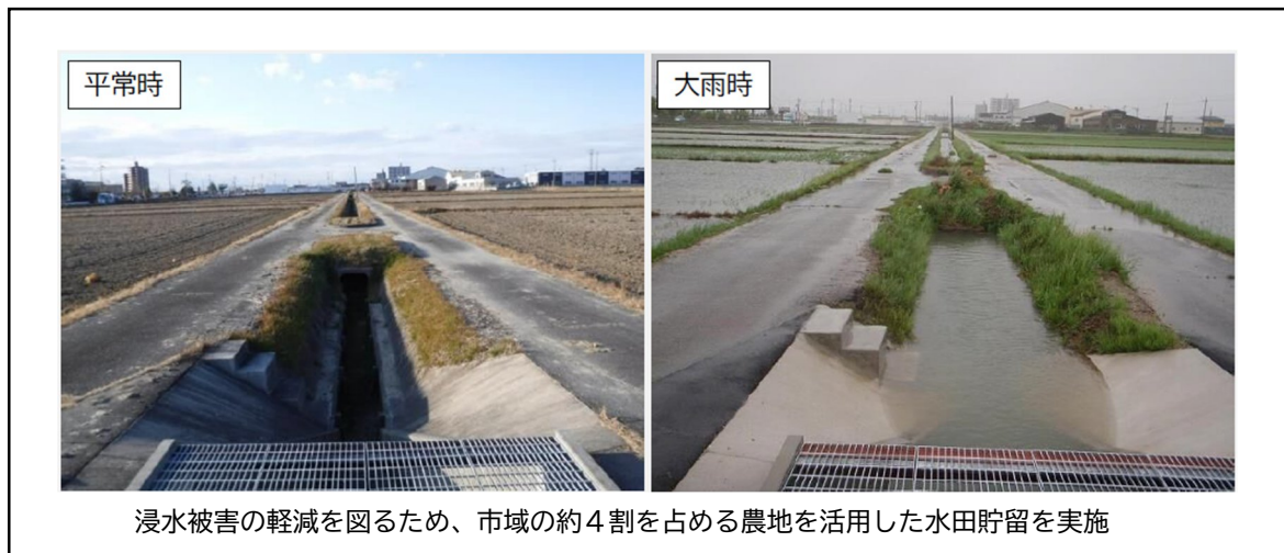
図 農地を活用したグリーンインフラの取組事例(愛知県安城市) 出典)「グリーンインフラ事例集」(令和7年(2025年)3月、グリーンインフラ官民連携プラットフォーム企画・広報部会)
