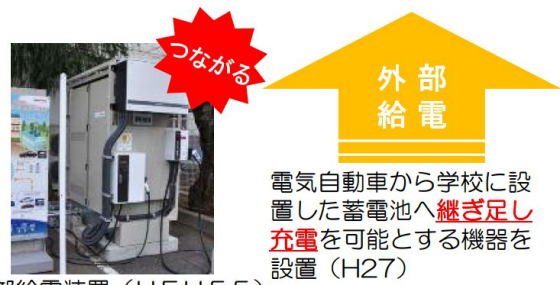
外部給電装置 (HEH55)
