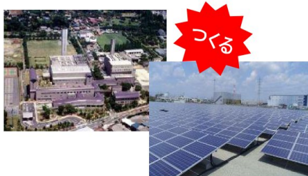
地域の自立分散型電源 (ごみ発電、メガソーラー)
