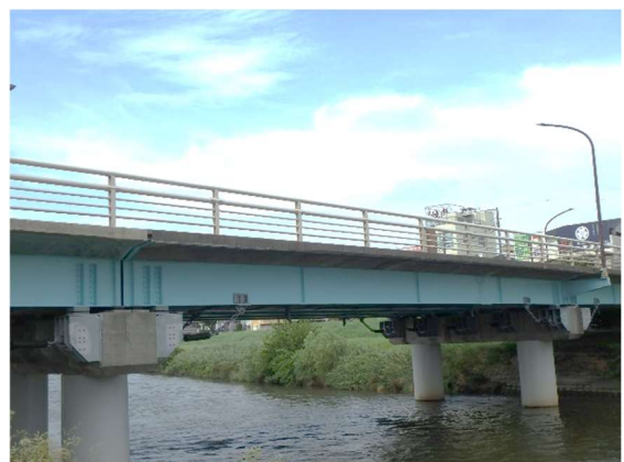
落橋防止装置（緩衝フェース）の設置
