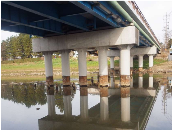
橋脚鋼板巻立て補強
