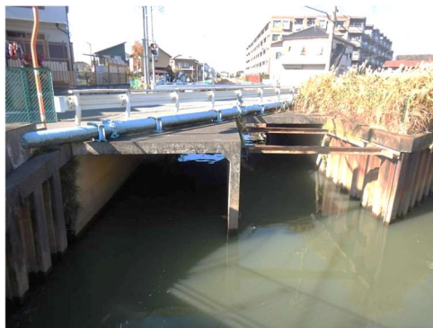
図1 溝橋構造の橋梁（七間橋）
