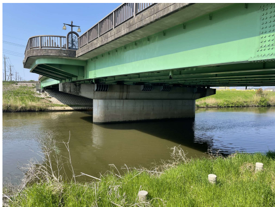
橋脚コンクリート巻立て補強
