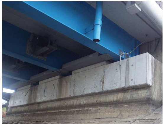
落橋防止装置・変位制限装置の設置
