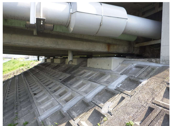
落橋防止装置（橋座拡幅）の設置
