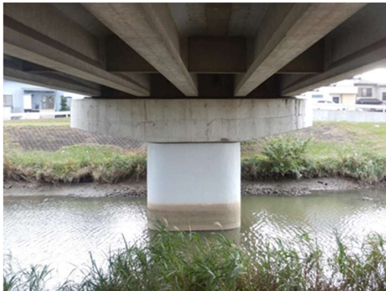
橋脚コンクリート巻立て補強
