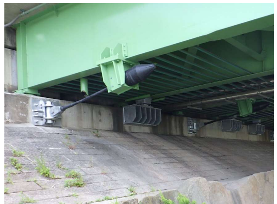
落橋防止装置（PCケーブル等）の設置
