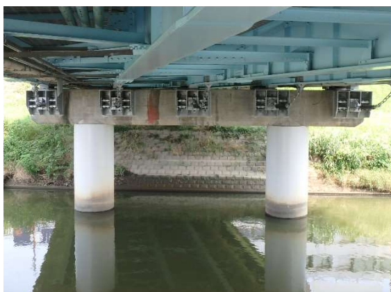
橋脚コンクリート巻立て補強
