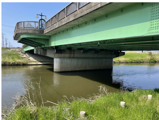
橋脚コンクリート巻立て補強
