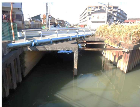
図1 溝橋構造の橋梁（七間橋）
