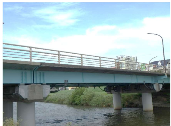
落橋防止装置（緩衝フェンス）の設置
