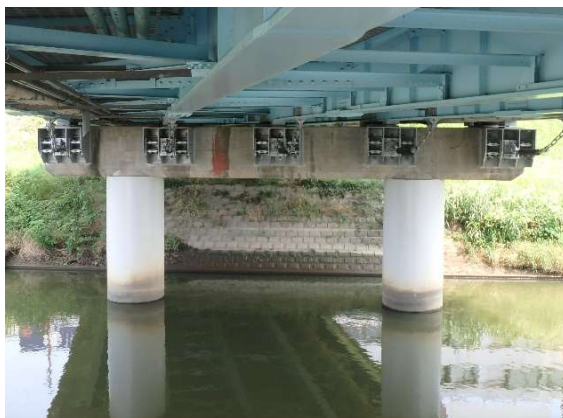
橋脚コンクリート巻立て補強
