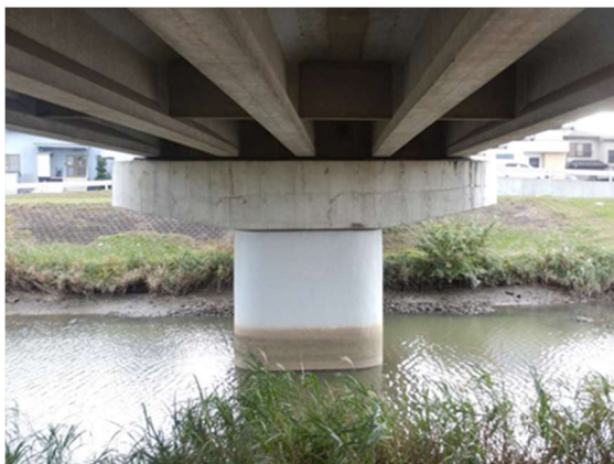
橋脚コンクリート巻立て補強
