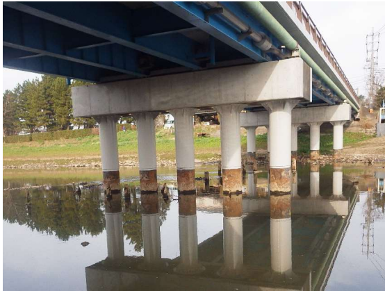
橋脚鋼板巻立て補強
