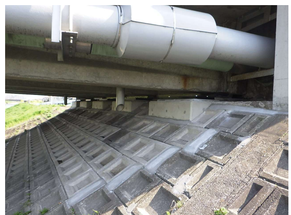
落橋防止装置（橋座拡幅）の設置
