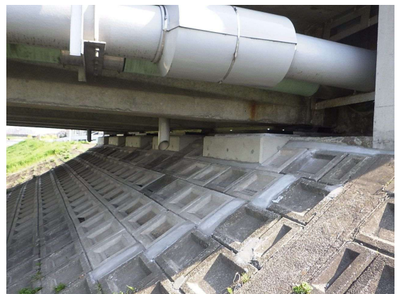
落橋防止装置（橋座拡幅）の設置
