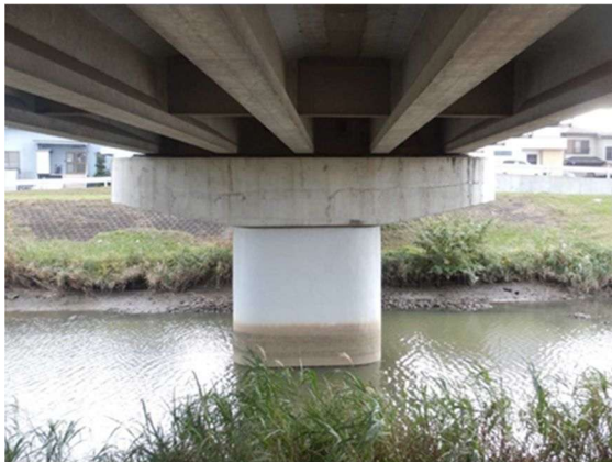
橋脚コンクリート巻立て補強
