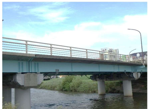
落橋防止装置（緩衝装置）の設置
