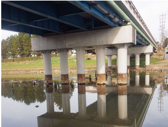
橋脚鋼板巻立て補強
