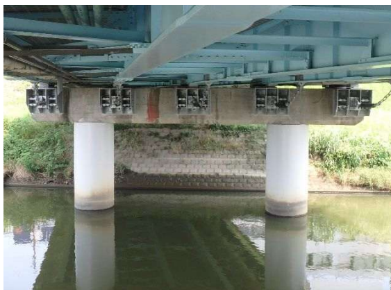
橋脚コンクリート巻立て補強
