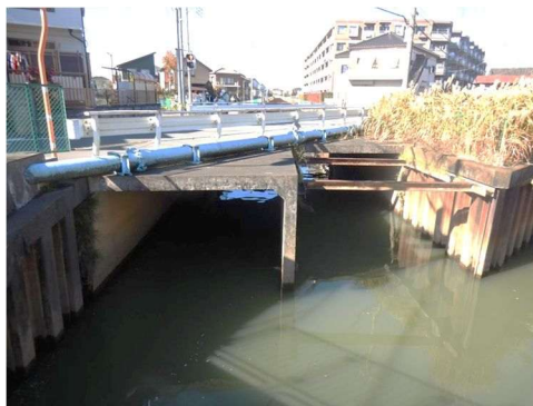
図1 溝橋構造の橋梁（七間橋）
