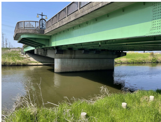
橋脚コンクリート巻立て補強
