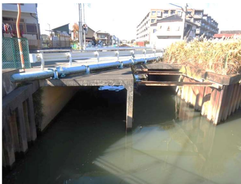
図1 溝橋構造の橋梁（七間橋）
