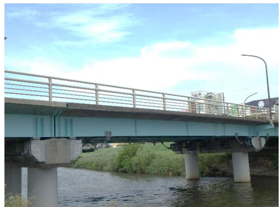
落橋防止装置（緩衝フェース）の設置
