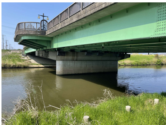
橋脚コンクリート巻立て補強
