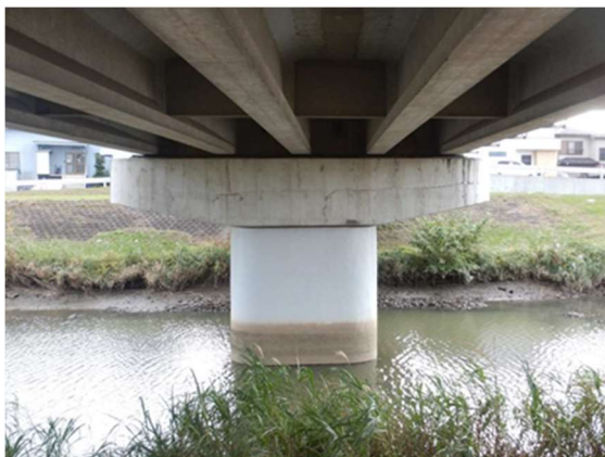
橋脚コンクリート巻立て補強
