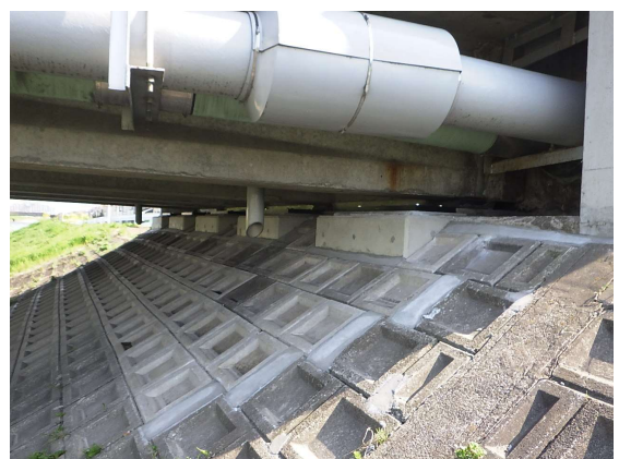
落橋防止装置（橋座拡幅）の設置
