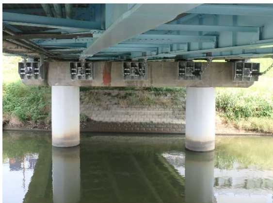
橋脚コンクリート巻立て補強
