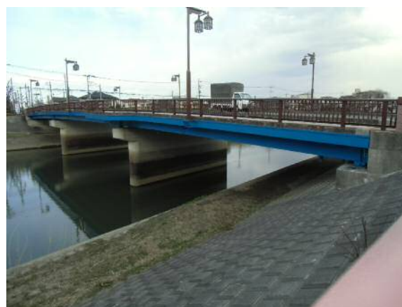
補修工事完了
