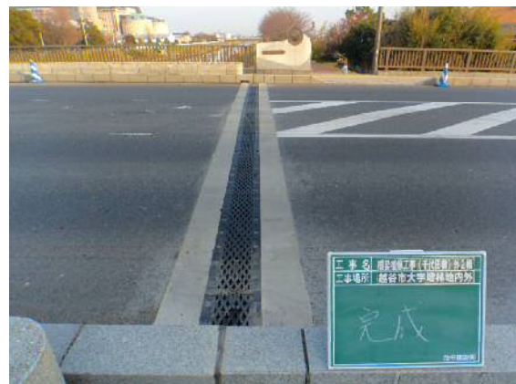
補修工事完了
