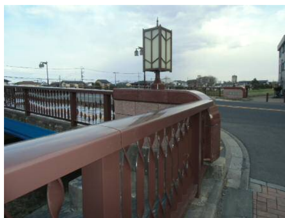
補修工事完了
