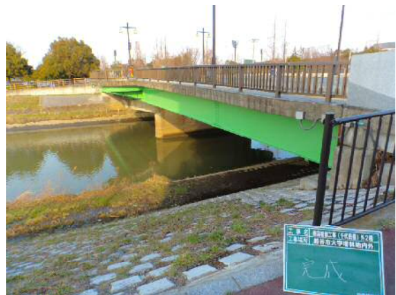
補修工事完了
