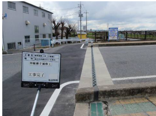
補修工事完了
