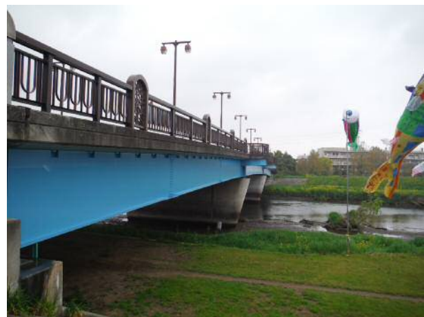
補修工事完了
