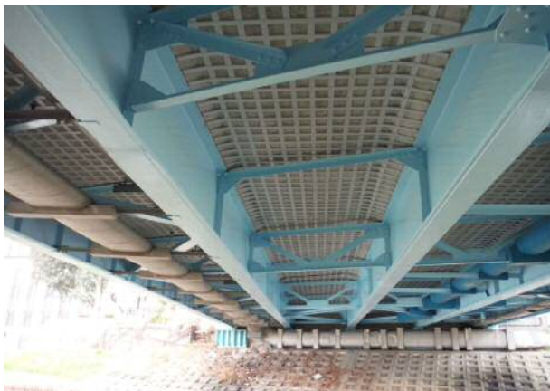
補修工事完了（炭素繊維プレート補強工）
