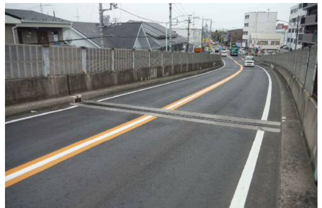
補修工事完了（伸縮装置取替え工）
