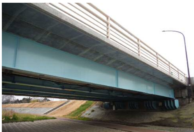
補修工事完了（剥落防止工）
