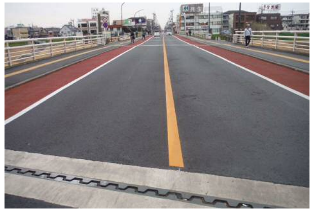
補修工事完了（橋面防水舗装、伸縮装置取替え）
