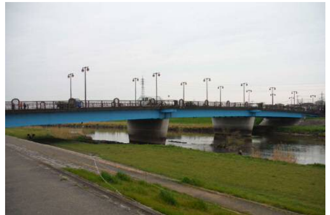
補修工事完了（主桁・支承塗装工）
