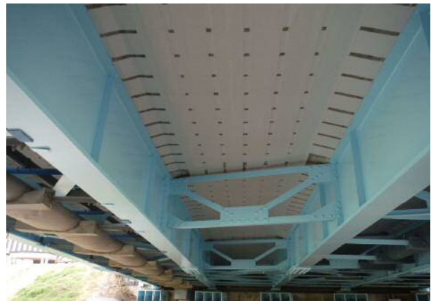
補修工事完了（炭素繊維シート補強工）
