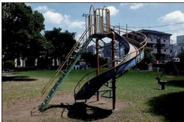
老朽化した公園施設
