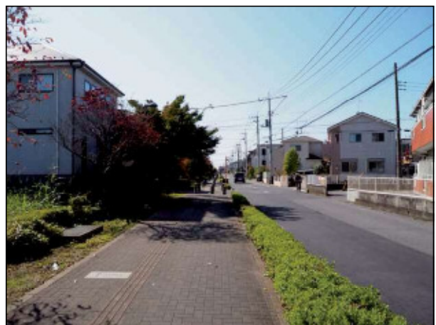
十分な歩行空間を確保した道路
