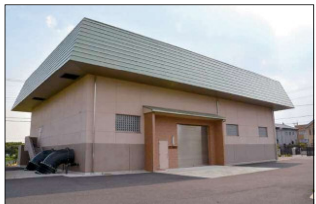
東町ポンプ場
