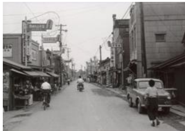
越ヶ谷商店街(越ヶ谷本町・中町) 【昭和30年代】
