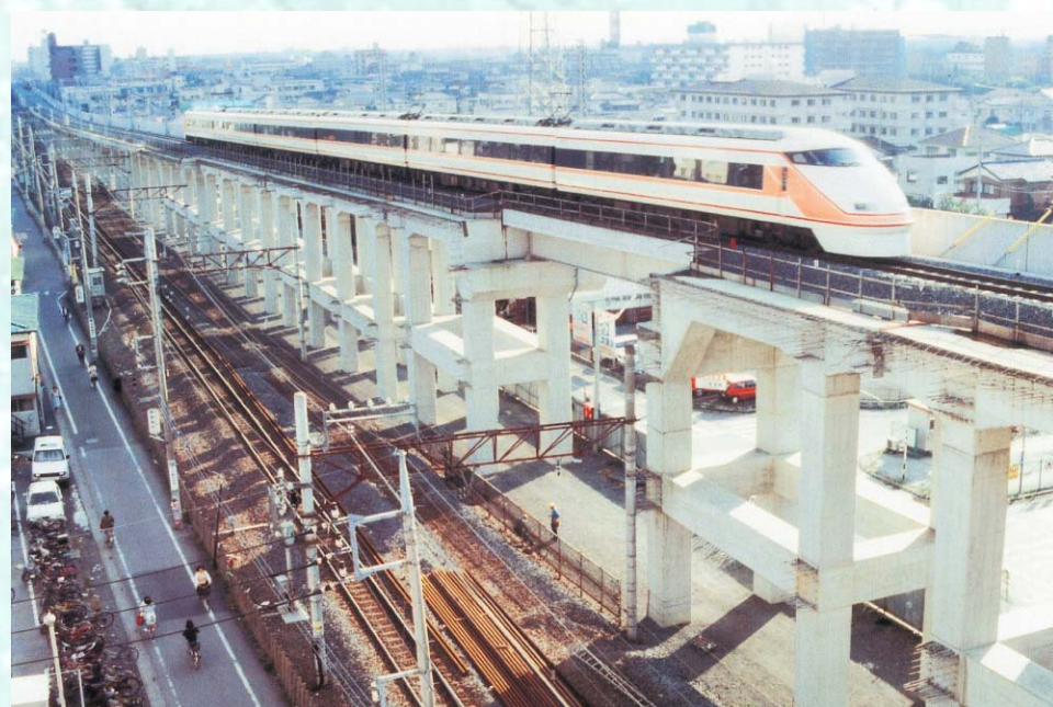
▲一部（下り）が高架となった東武鉄道伊勢崎線〔平成5年〕
