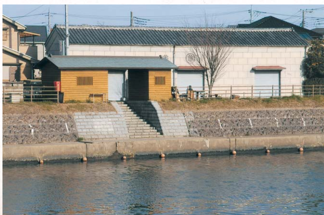
藤助河岸跡に復元された小屋
